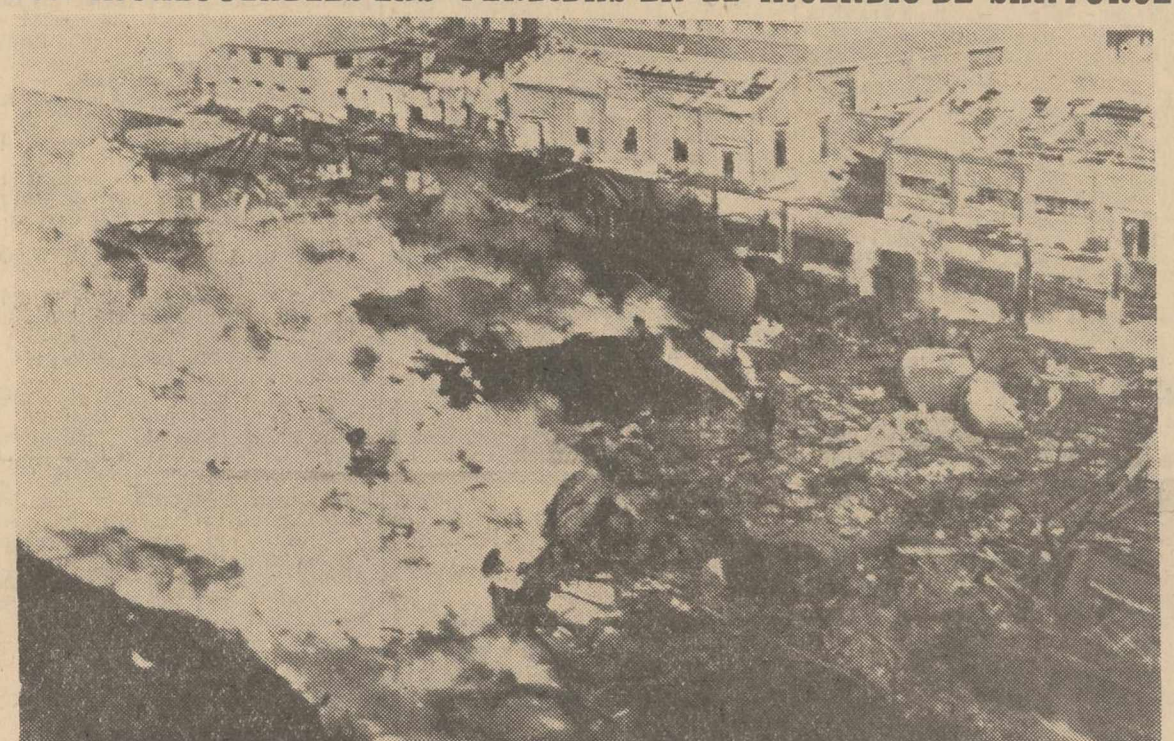
SANTURCE.—Aspecto general que presenta el siniestro que se produjo en las instalaciones de la CAMPSA en Santurce. Aún no se puede calcular el número de millones de pérdidas que ha producido el siniestro. (Telefoto EUROPA PRESS)
