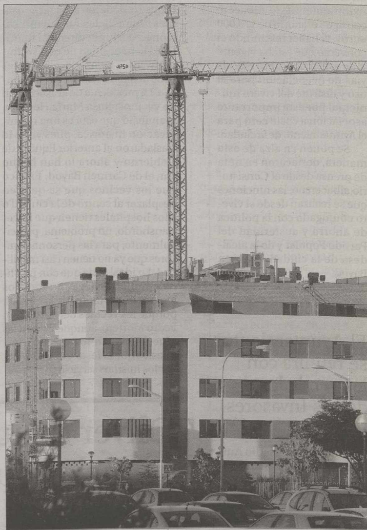
Edificio de viviendas en construcción en la capital. / REBECA SERNA
