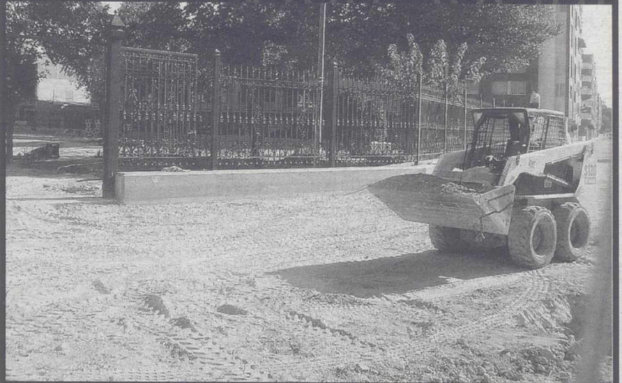
Reformas en el Parque de La Roda. Prosiguen en La Roda las obras de remodelación del Parque Central, uno de los principales proyectos financiados con cargo al FEIL, con un presupuesto de unos 800.000 euros. / C. JIMÉNEZ
