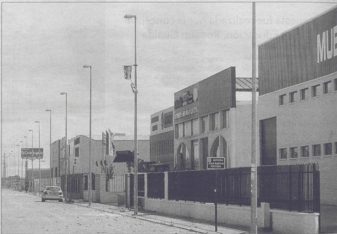
Varias empresas concentradas en uno de los polígonos de la provincia. / R. SERNA
