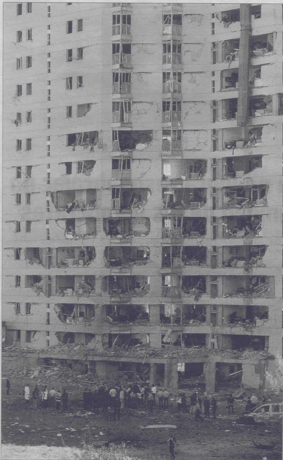
La imagen de la fachada de la casa cuartel, destrozada en sus pisos más bajos, revela la magnitud del ataque. / ÁNGEL AYALA
