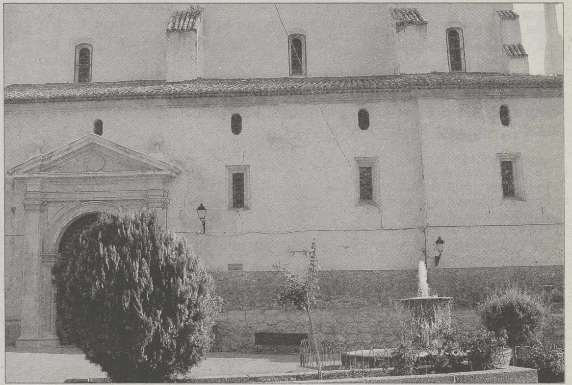
La Iglesia de la Asunción se encuentra en un estado ruinoso./G. GONZÁLEZ
