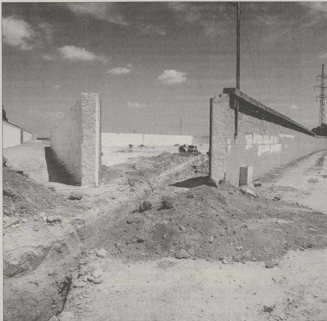
Pronto estarán acabadas las acometidas de agua y luz en el solar vallado. / ARTURO PEREZ
