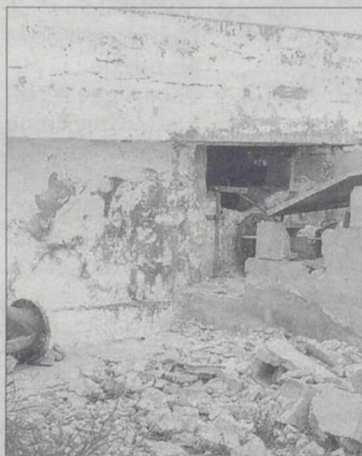
Situación del depósito de agua.
