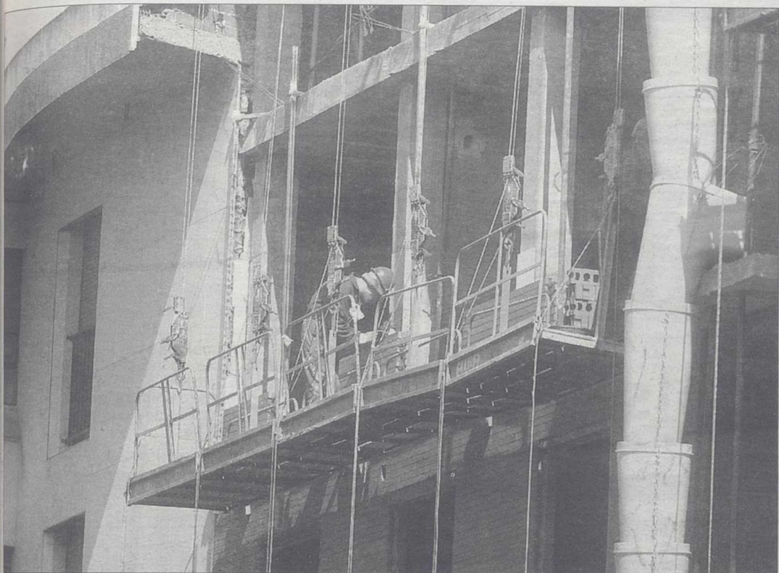
Trabajadores en un andamio, durante la construcción de unas viviendas en Valladolid. //JESÚS LUQUE
