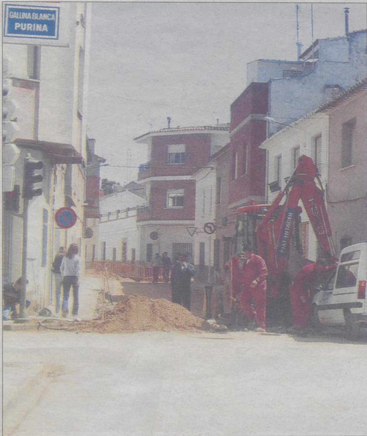
Obras en la calle Alfarerías Bajas de Villarrobledo. TERESA JIMÉNEZ
