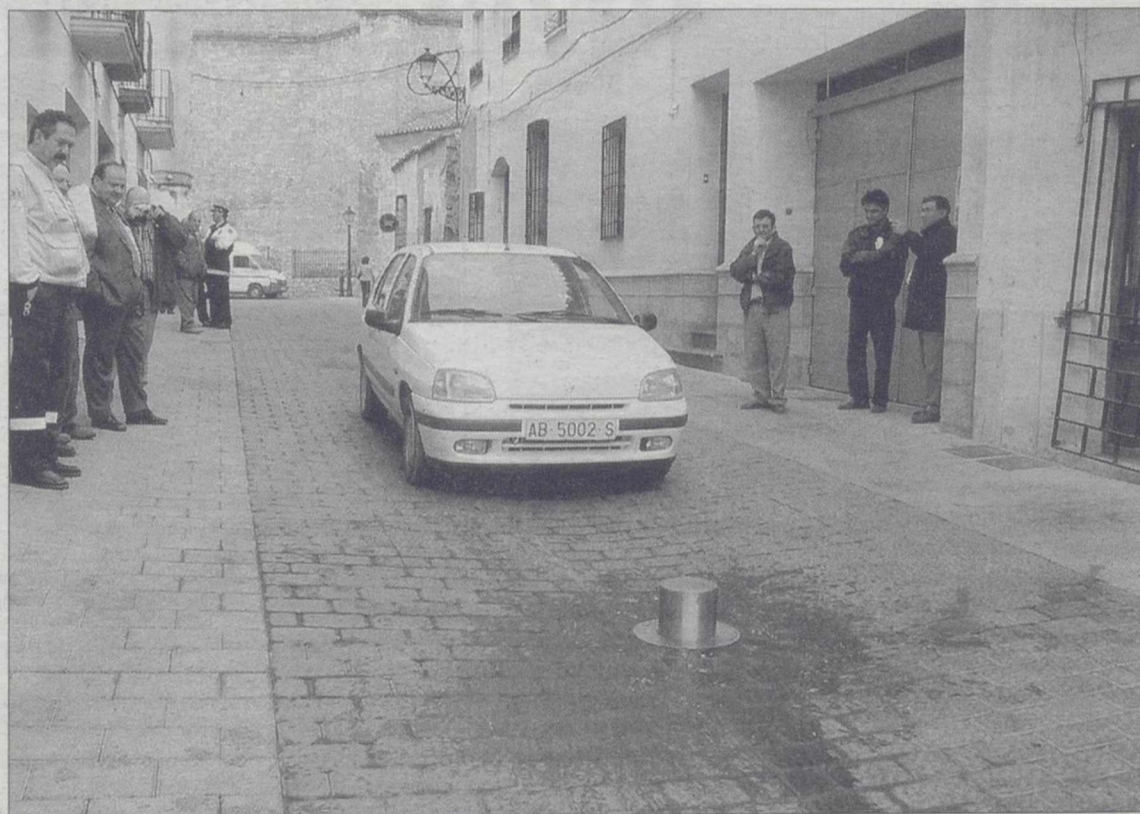
Se han instalado un total de cinco pilonas automáticas. / TERESA JIMÉNEZ
