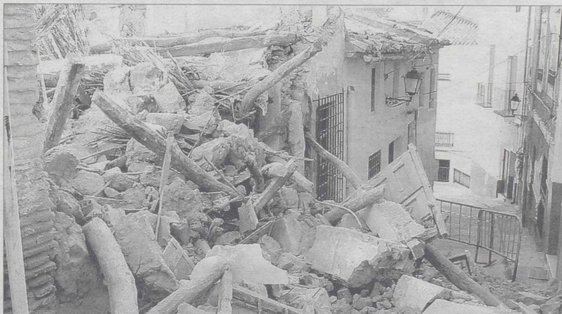
Estado actual de la calle afectada, tras el hundimiento./LA TRIBUNA
