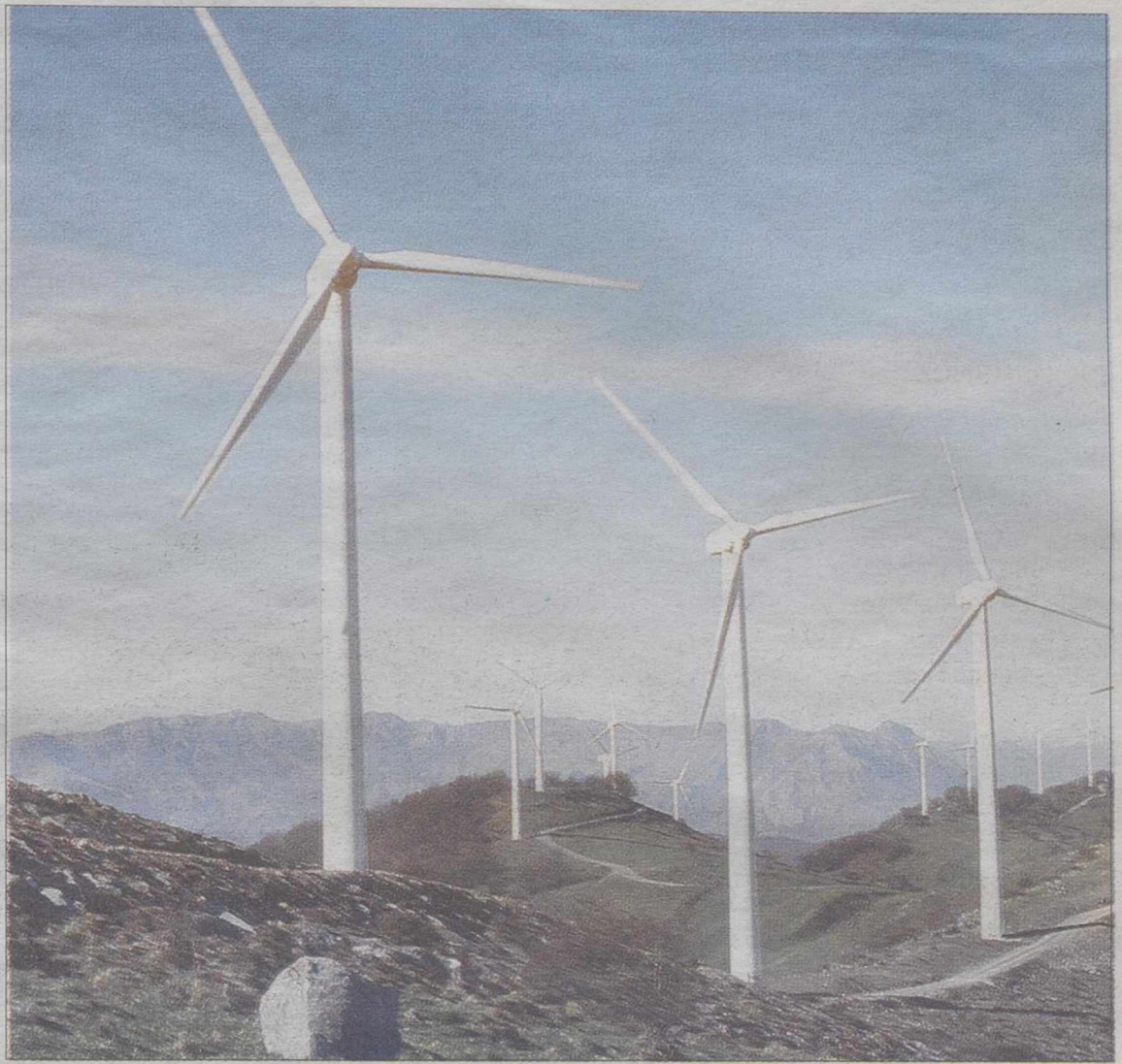
La instalación de equipos de medición, primer paso para la ubicación de parques eólicos en el término municipal.
