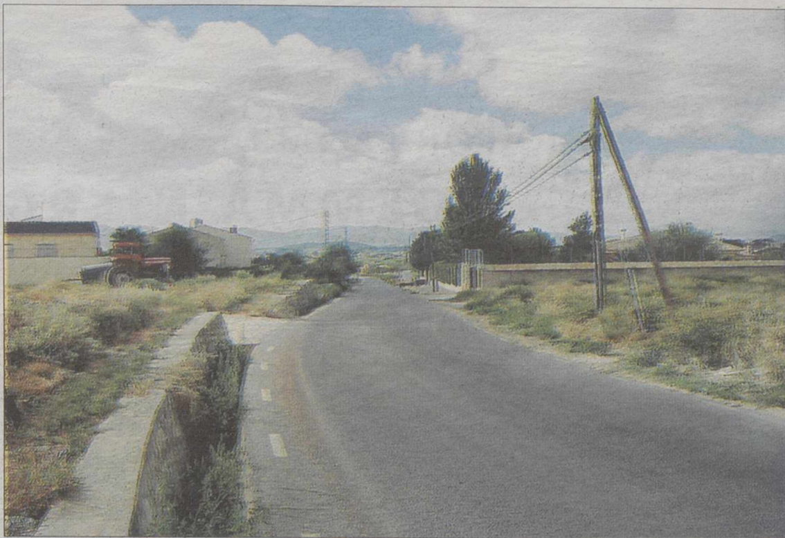
La carretera objetada por el PP, en su estado actual./LA TRIBUNA
