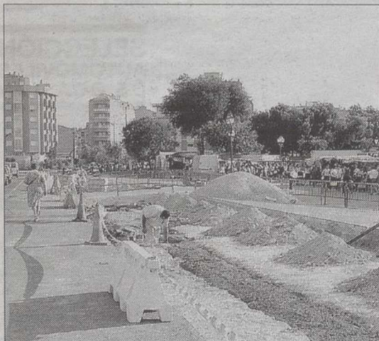
Obras de la II fase a la altura del Recinto Ferial.
