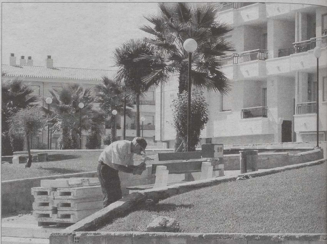
Los obreros ya están trabajando en la Plaza de Juan Carlos I. / ANGEL ROMERO
