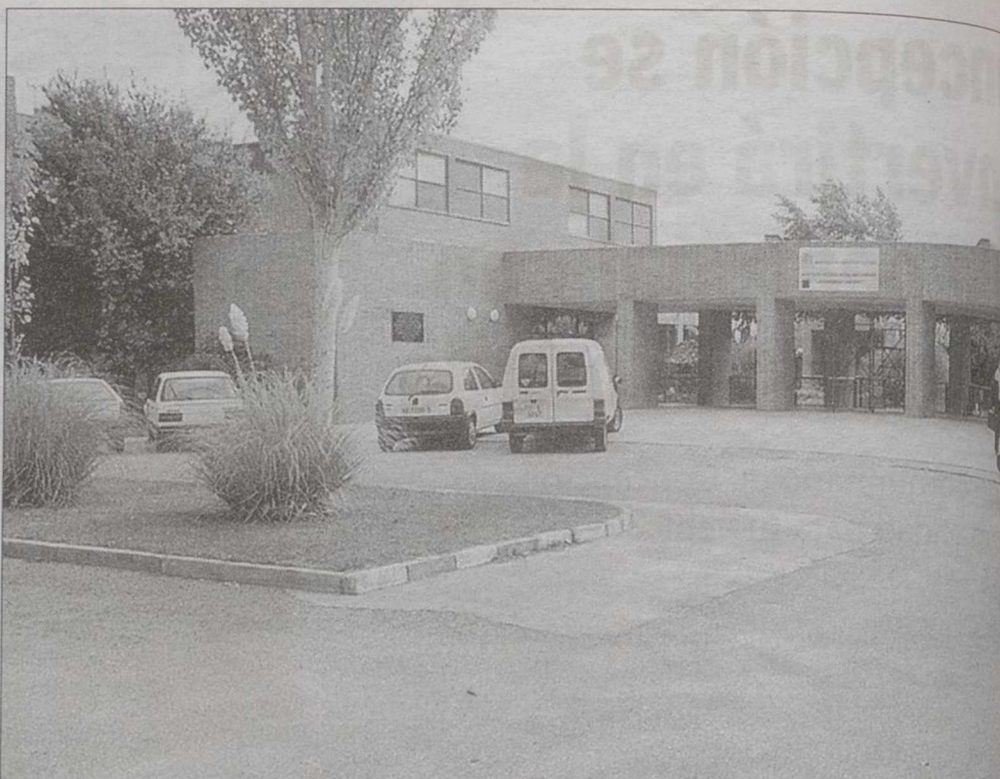
La Universidad Laboral es uno de los IES en donde se continúa con la ejecución de acometidas diversas./LA TRIBUNA
