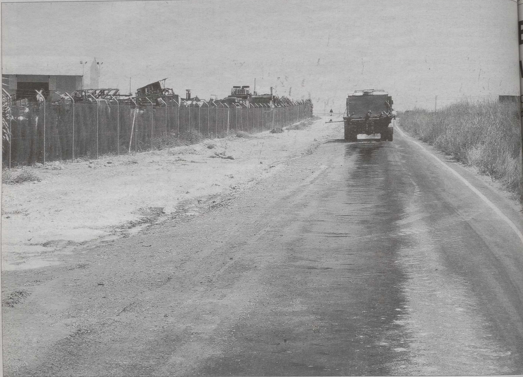
Obras en el camino de San Clemente. / TERESA JIMÉNEZ
