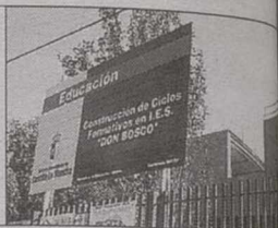
Las obras se realizan aprovechando el período de vacaciones.
