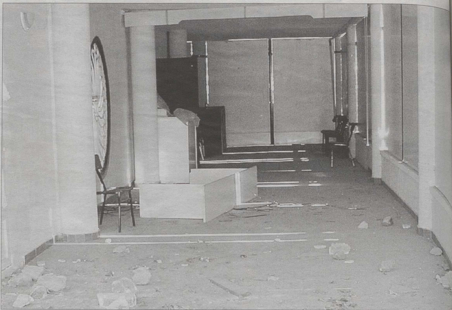
Aspecto que presenta actualmente el edificio de la capilla./ANGEL ROMERO
