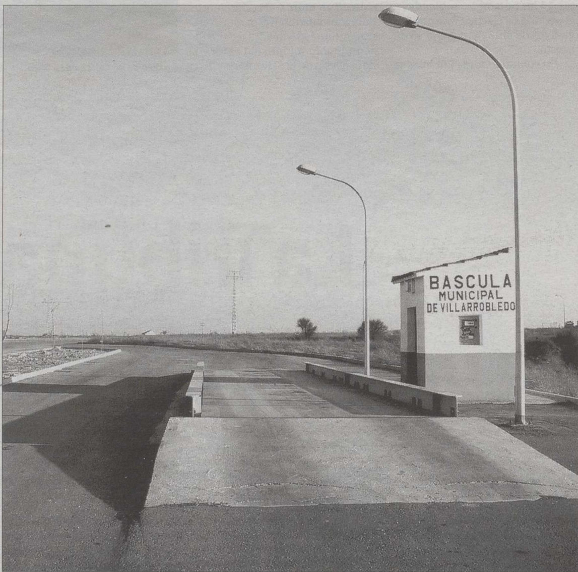
El «Punto Limpio» se construirá detrás de la Báscula Municipal.. /TERESA JIMÉNEZ
