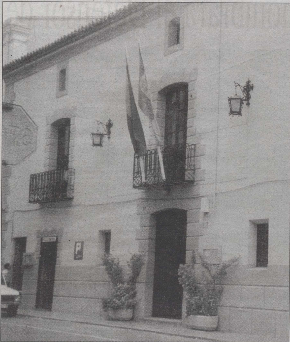
Caudete viene sufriendo importantes problemas de abastecimiento de agua potable.
