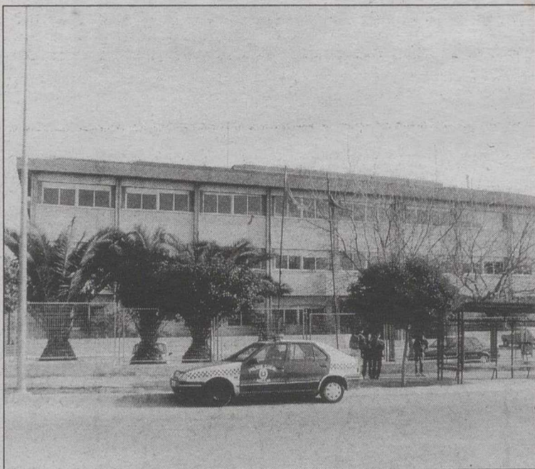
Finalizaron las tareas de reparación.
