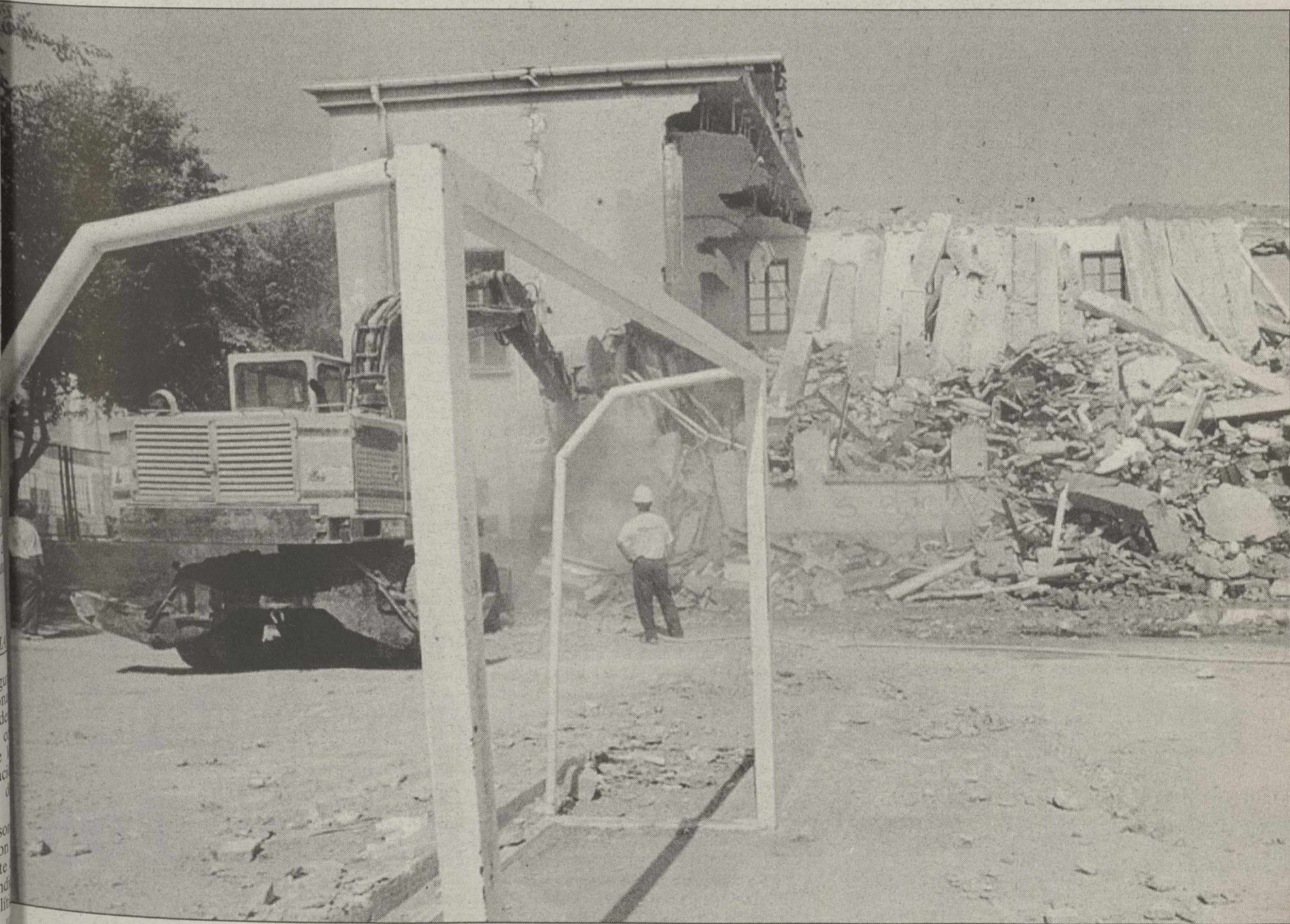
Las máquinas comenzaron ayer a demoler el edificio del Colegio Benjamín Palencia de Barrax.
