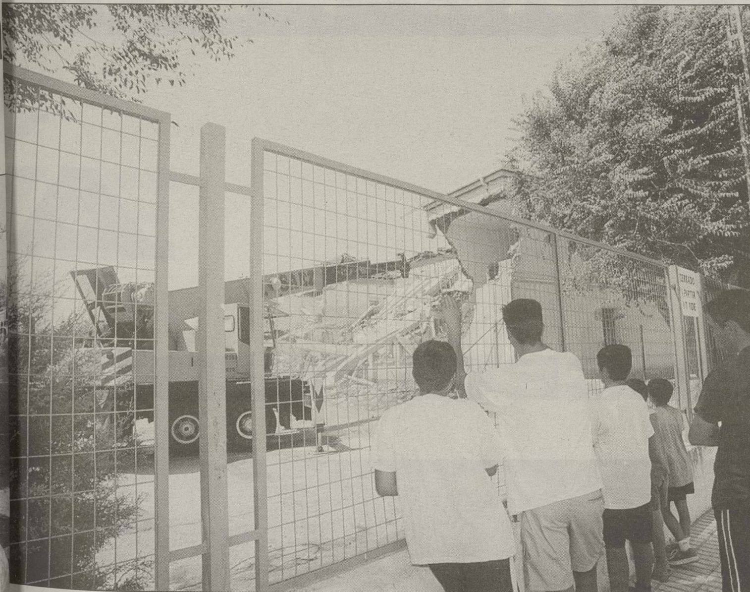
El derribo del edificio genera gran expectación entre los chavales que recibieron clases entre esas cuatro paredes.
