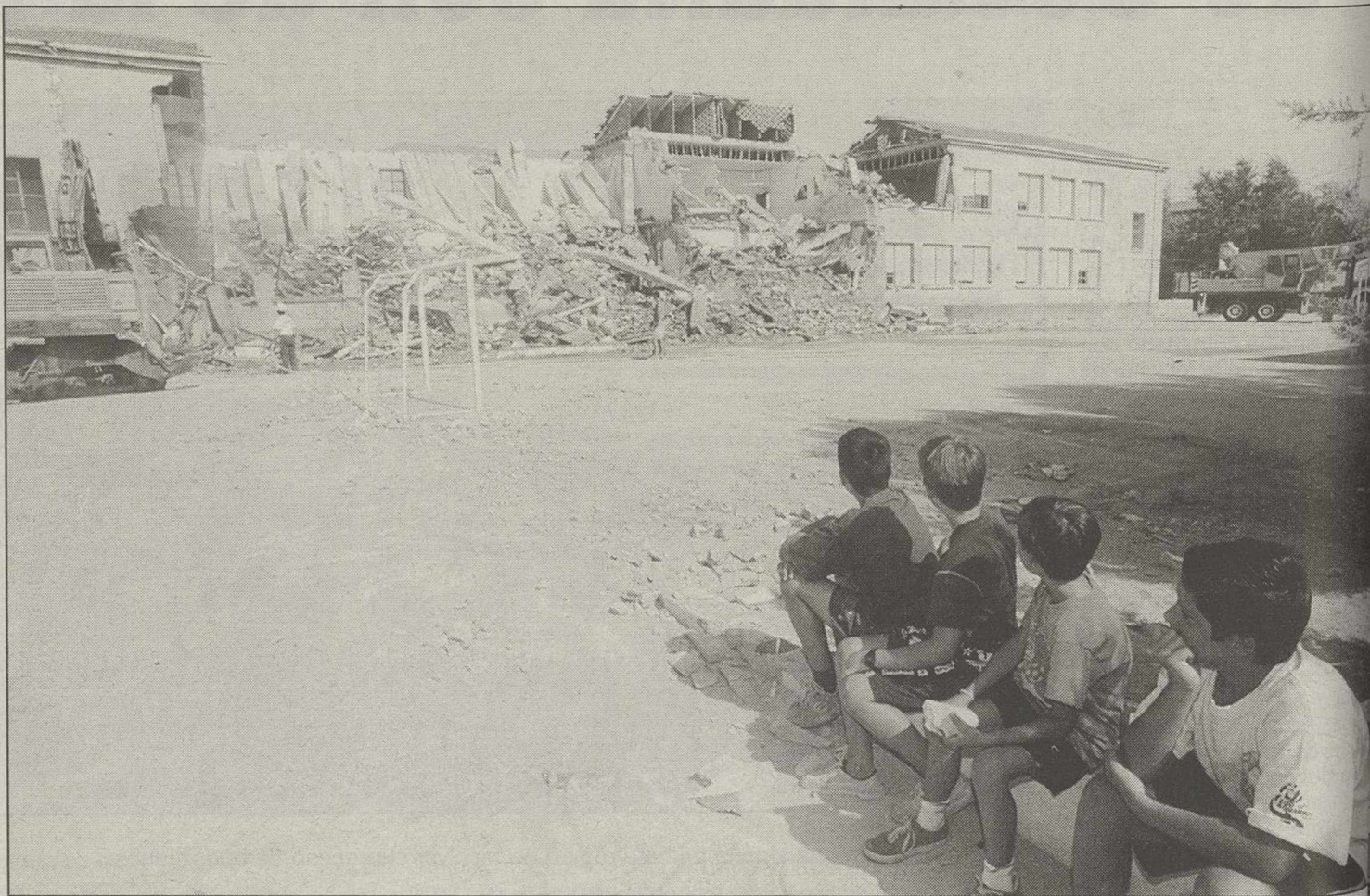
Las obras de demolición del colegio Benjamín Palencia comenzaron ayer.
