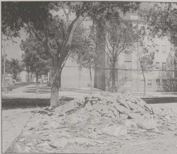
Los escombros no han sido retirados.
