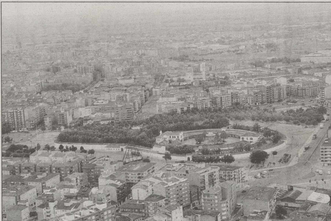
Estas instalaciones de pararrayos no son más efectivas que las convencionales.
