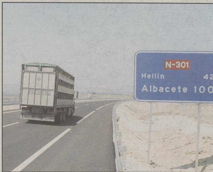
Las obras en la autovía a Murcia provocaron la avería.
