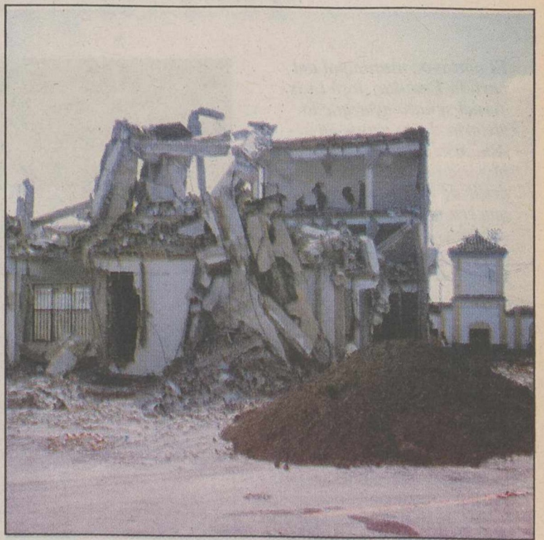
Hellín perdió un instituto tras el derribo del Lope de Vega.
