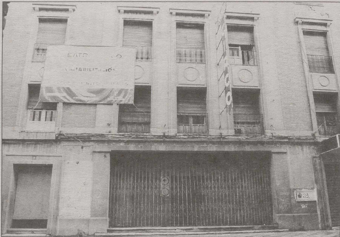
Las obras se iniciarán con la demolición de las viviendas anexas a la fachada.
