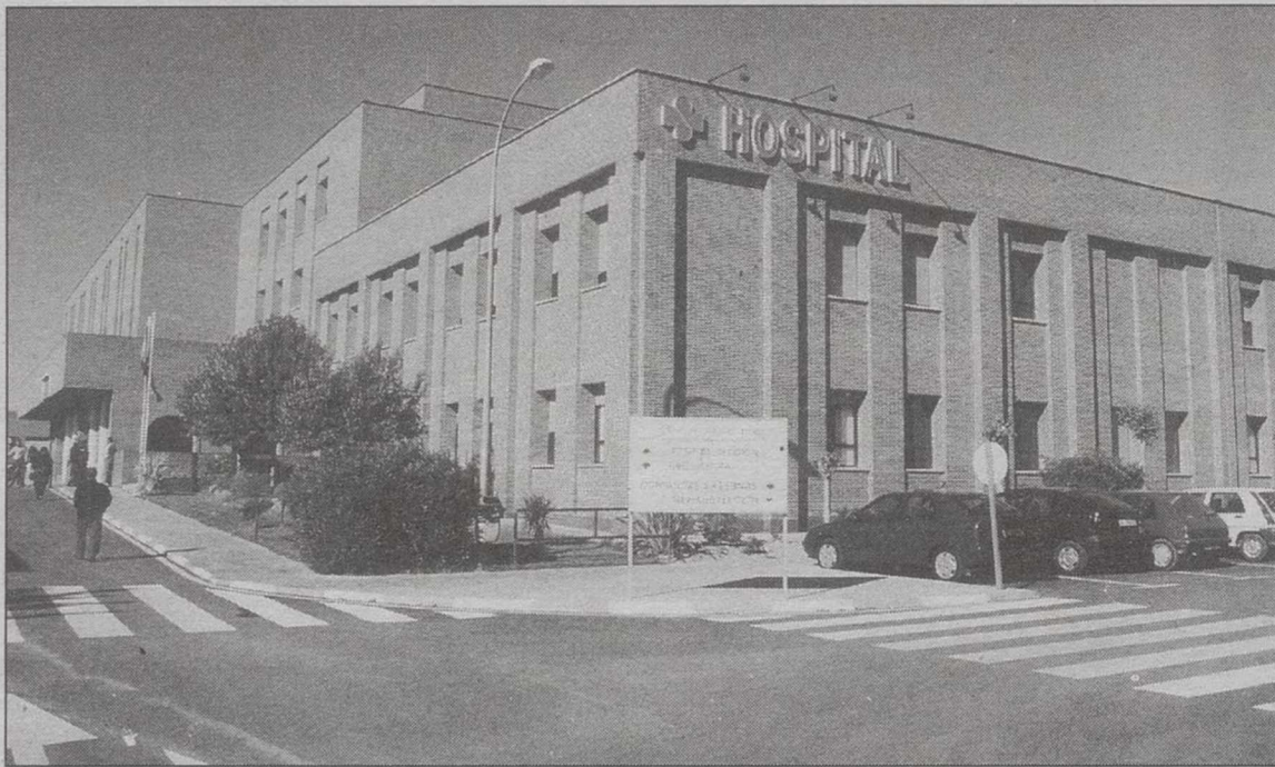
El centro sanitario hellinero continúa incrementando y mejorando sus infraestructuras.
