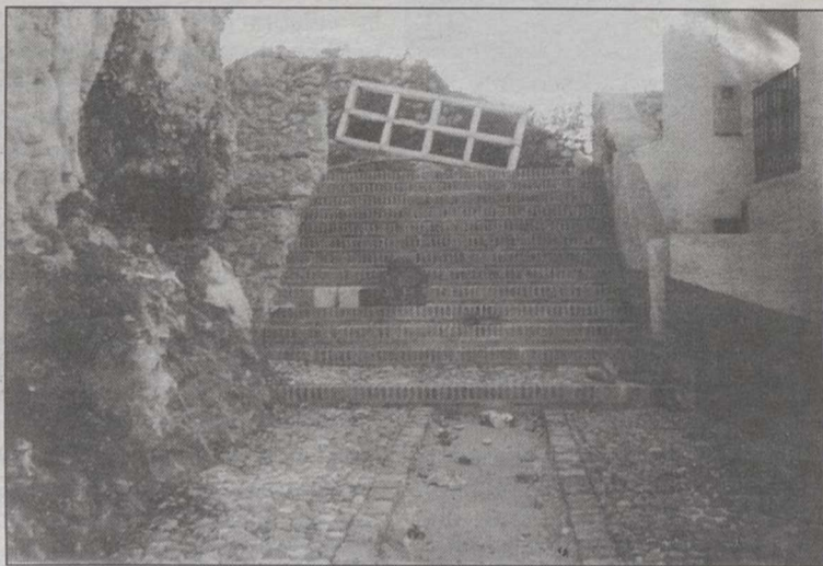
Las escaleras impiden el tránsito normal de numerosos vecinos de la localidad.
