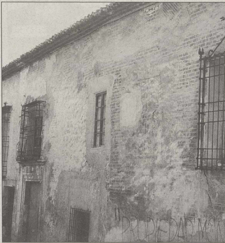
Se realizan sondeos o "catas" en el patio de la Casa del Conde.
