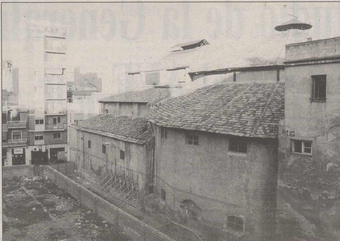
La Asociación Cultural reitera que el edificio corre un grave peligro de hundimiento.
