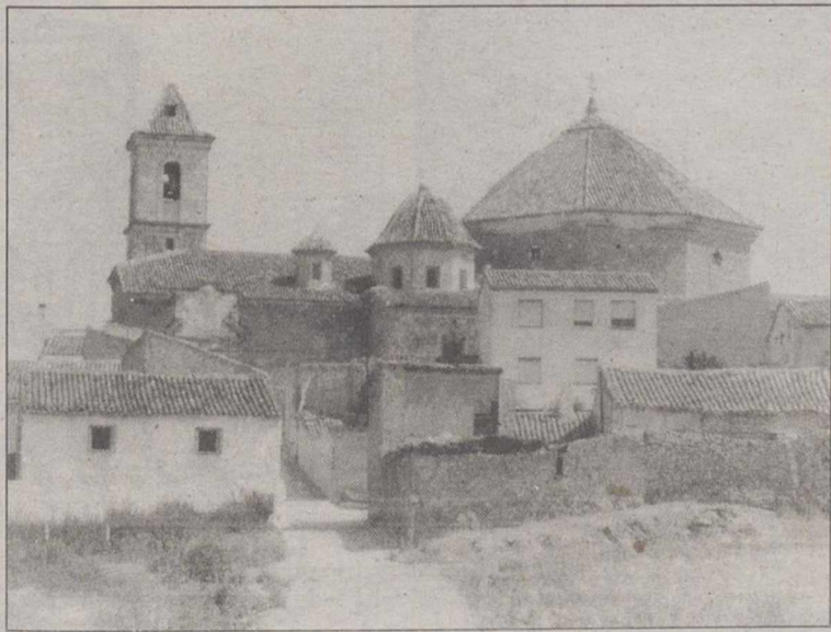
El Reloj de la Torre es uno de los trabajos que se van a iniciar.
