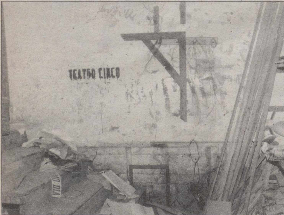
El inmueble se encuentra hoy en un penoso estado de abandono.
