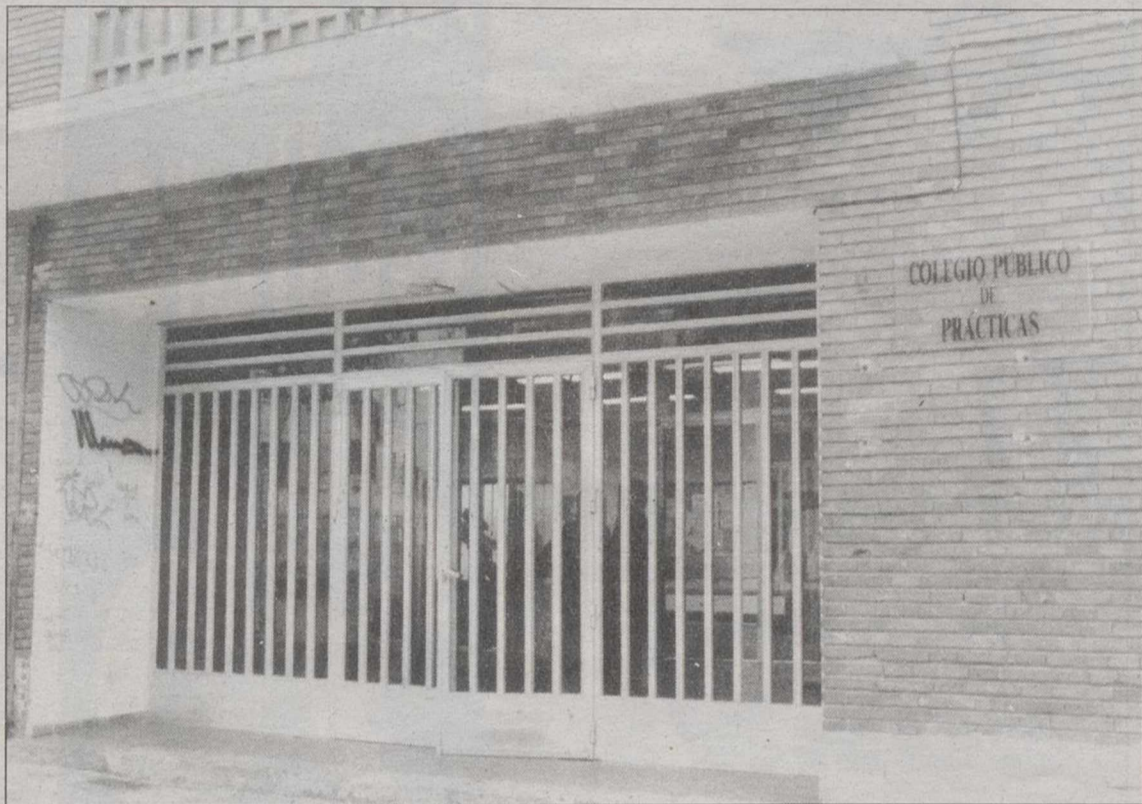
En varias ocasiones los padres han denunciado deficiencias en su estructura y han demandado al MEC su arreglo.
