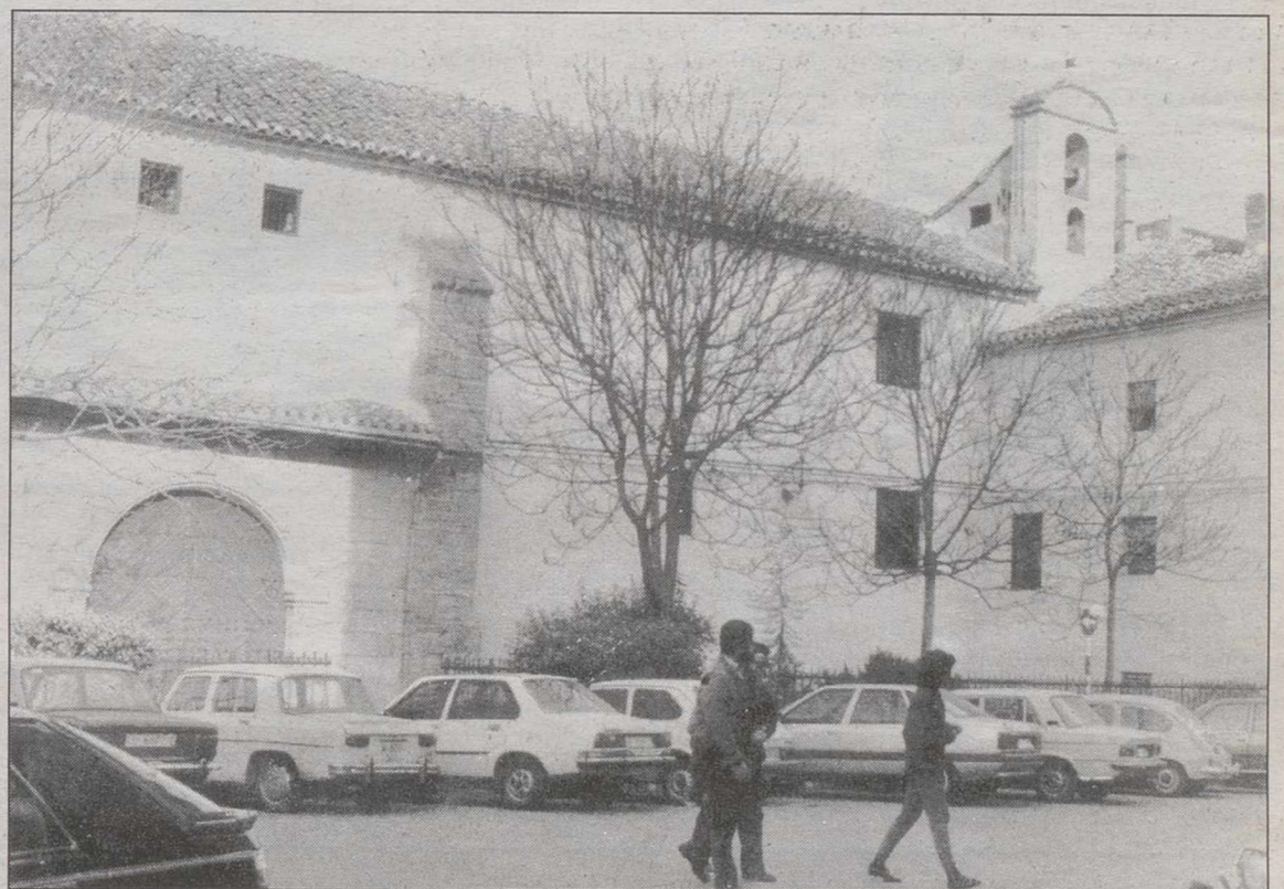
La primera fase de las obras ha comenzado ya en la Calle de San Bernardo.
