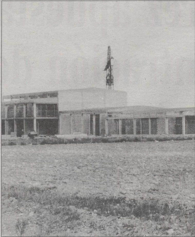
El nuevo matadero municipal ya está listo para empezar a funcionar.
