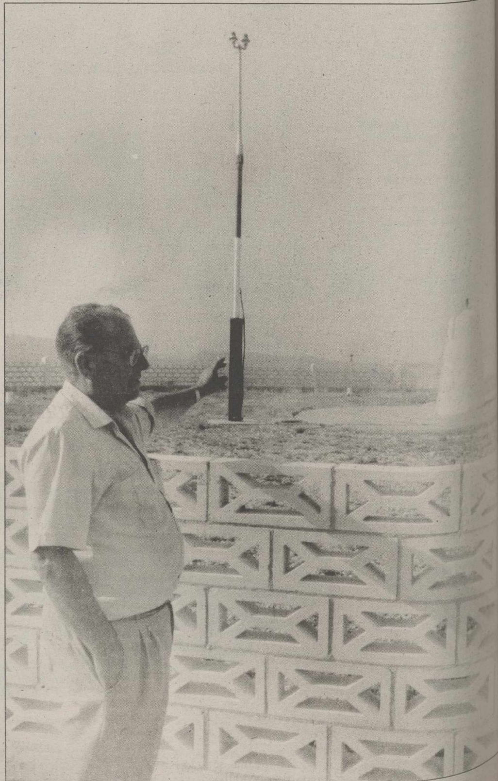
Las antenas de este VOR están situadas en plena cima del monte Ardal.
