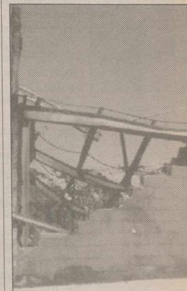
La fábrica quedó destruida.
