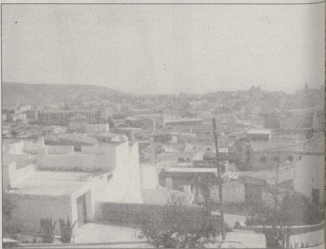
Balace del recientemente terminado 93 en Hellín.
