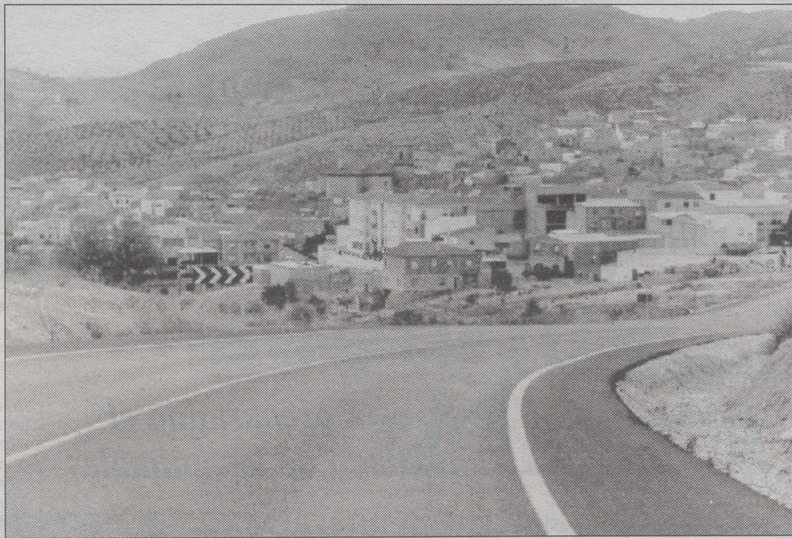
La Consejería de Obras Públicas acondicionará algunas carreteras de la provincia.
