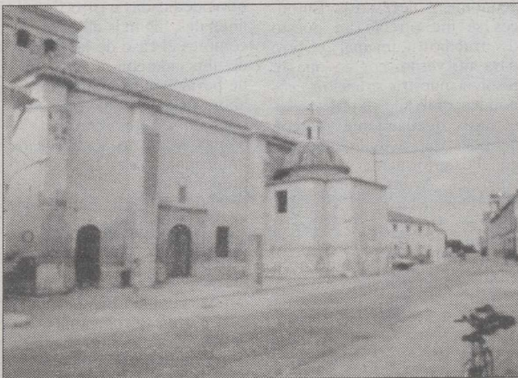
En Bonete se construirán 20 viviendas.
