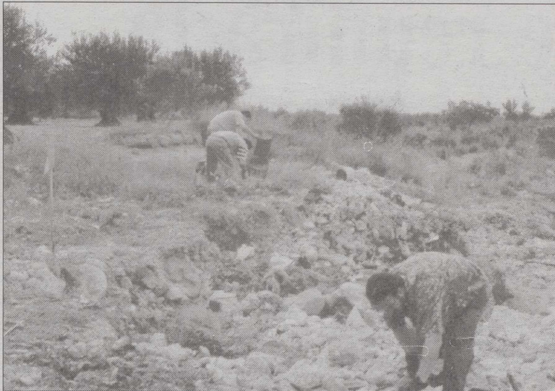
La Concejalía de Medio Ambiente ha informado de la apertura de una escombrera.
