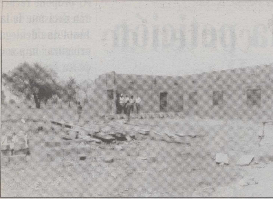
Estado de las obras del centro materno-infantil en Hounde en febrero de 1992.
