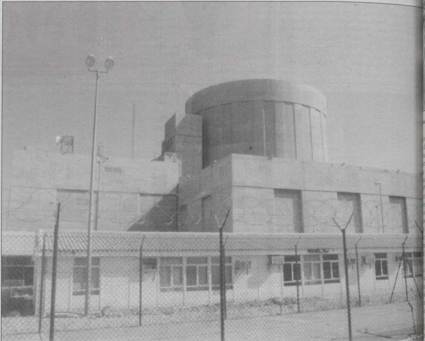
Vista exterior del edificio del reactor y combustible.
