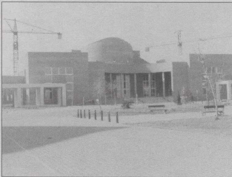
Edificio de Servicios Generales y Aula Magna del campus de Albacete.
