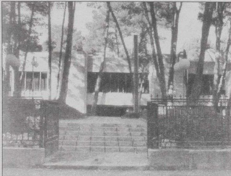
Hace ya varios años que el Museo necesita la reparación de sus sótanos.
