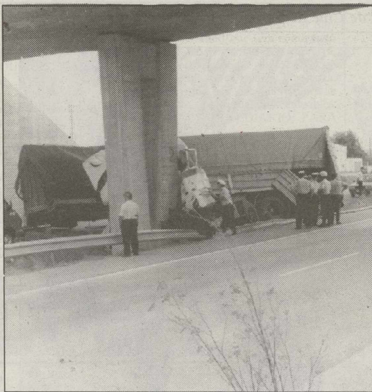
El camión se estrelló frontalmente contra uno de los pilares del puente.
