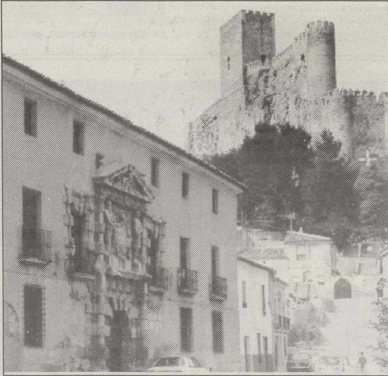
Las viviendas afectadas están situadas en el casco antiguo de la ciudad
