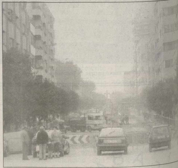
Obras en la Gran Vía.
