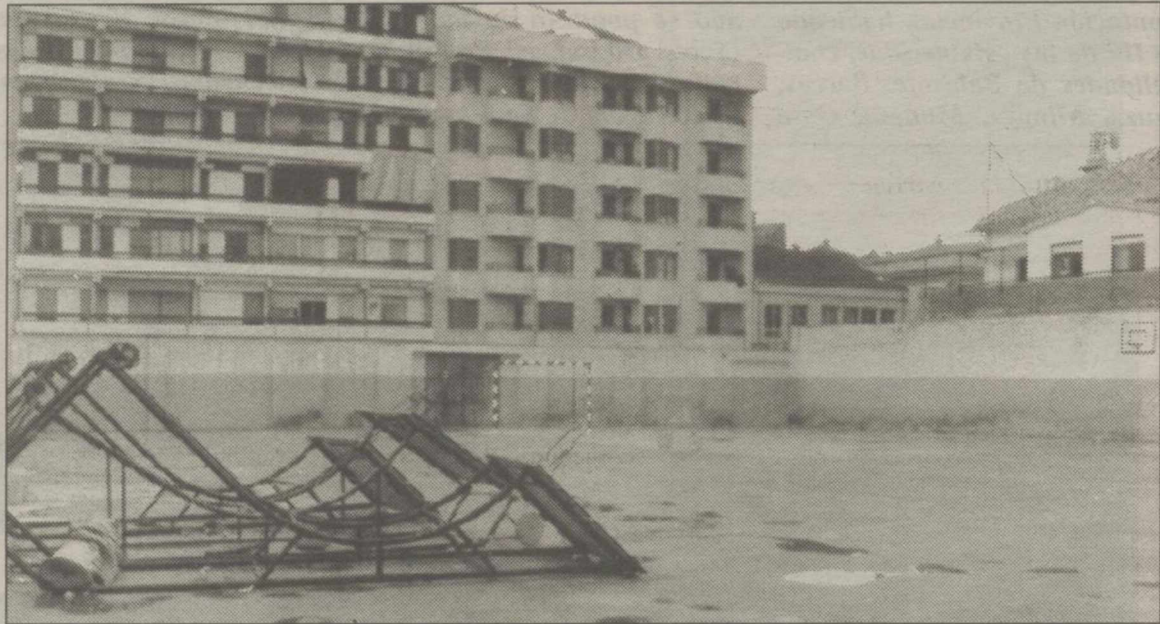
En la fotografía se observa el lugar donde se efectuarán las obras de ampliación.
