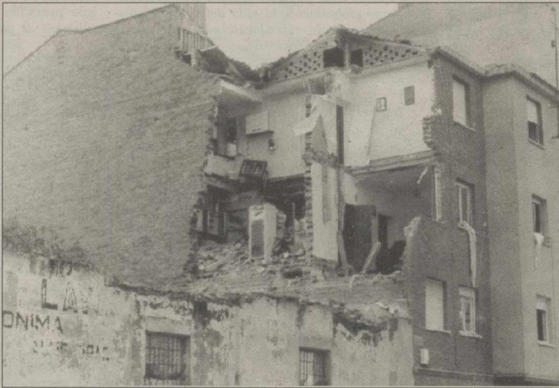
Los vecinos afectados por la explosión de gas continúan en casa de sus familiares.
