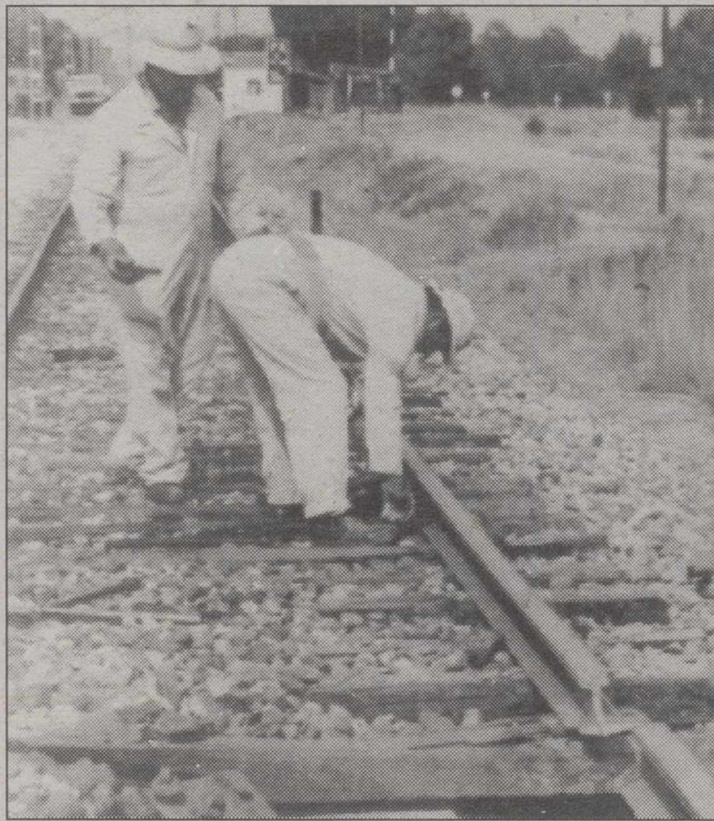
Varios operarios reparan las vías férreas.
