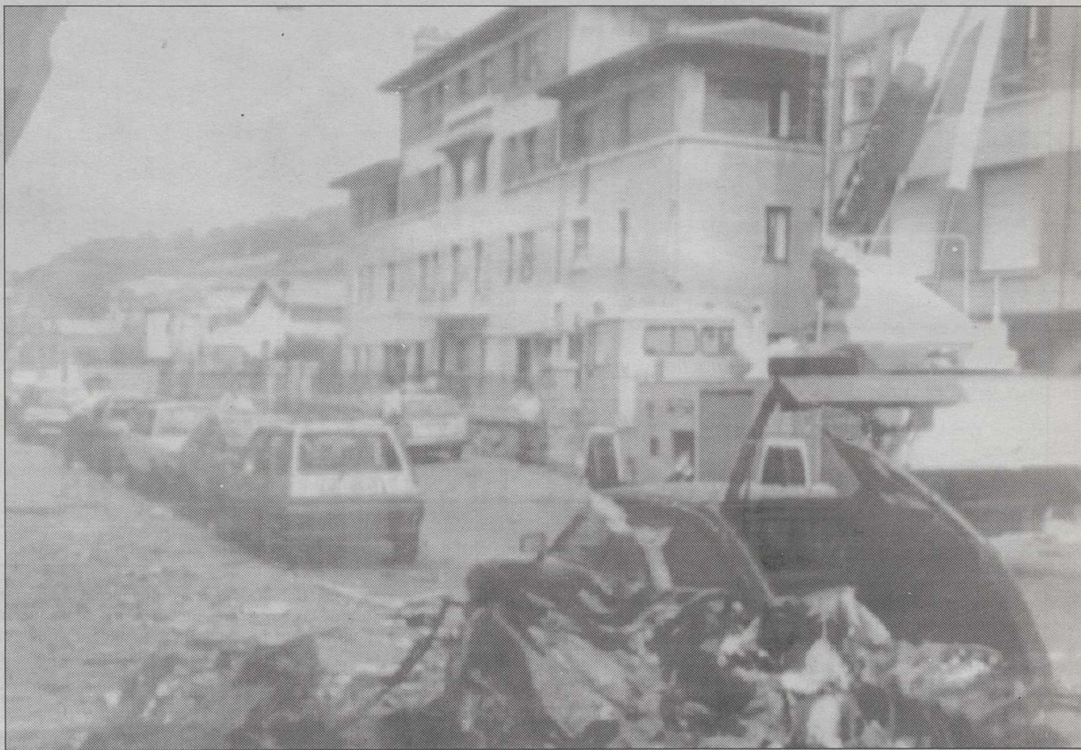
Estado en que quedó el coche-bomba. En segundo plano, el edificio de viviendas de la Guardia Civil.
