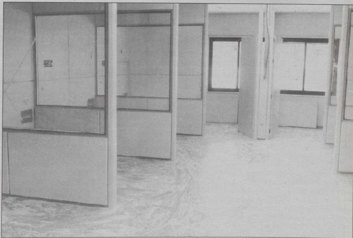
Las obras de ampliación y reforma del servicio de urgencias eran ya muy necesarias.
