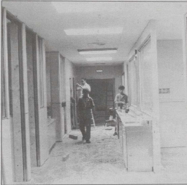
(Pág. 5) Las obras de ampliación y reforma eran ya muy necesarias.
