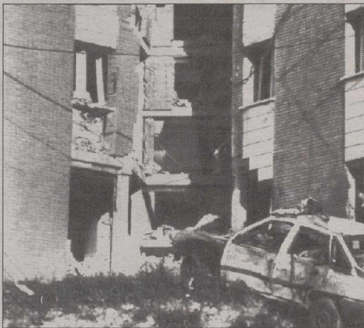
La explosión causó importantes destrozos en el cuartel de la Benemérita.
